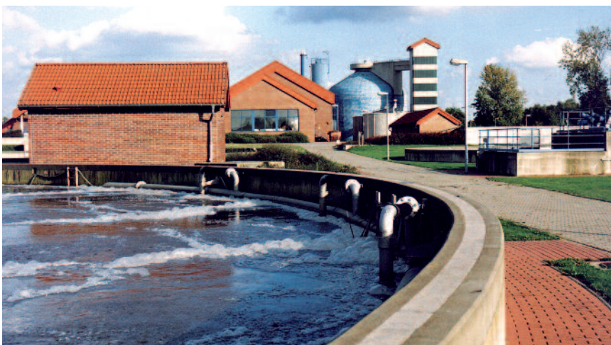
Silber-Nanopartikel, etwa bei Textilien eingesetzt, können den Reinigungsprozess in Kläranlagen beeinträchtigen.
